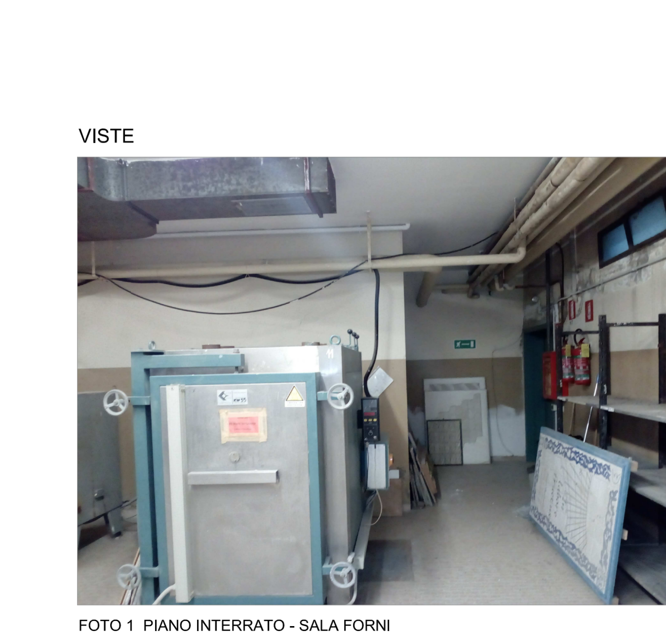
FOTO 1 PIANO INTERRATO - SALA FORNI
