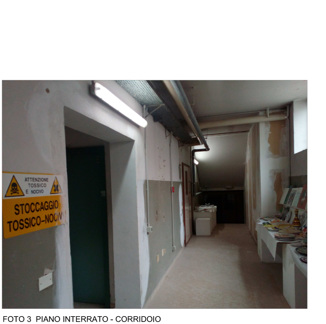
FOTO 3 PIANO INTERRATO - CORRIDOIO
