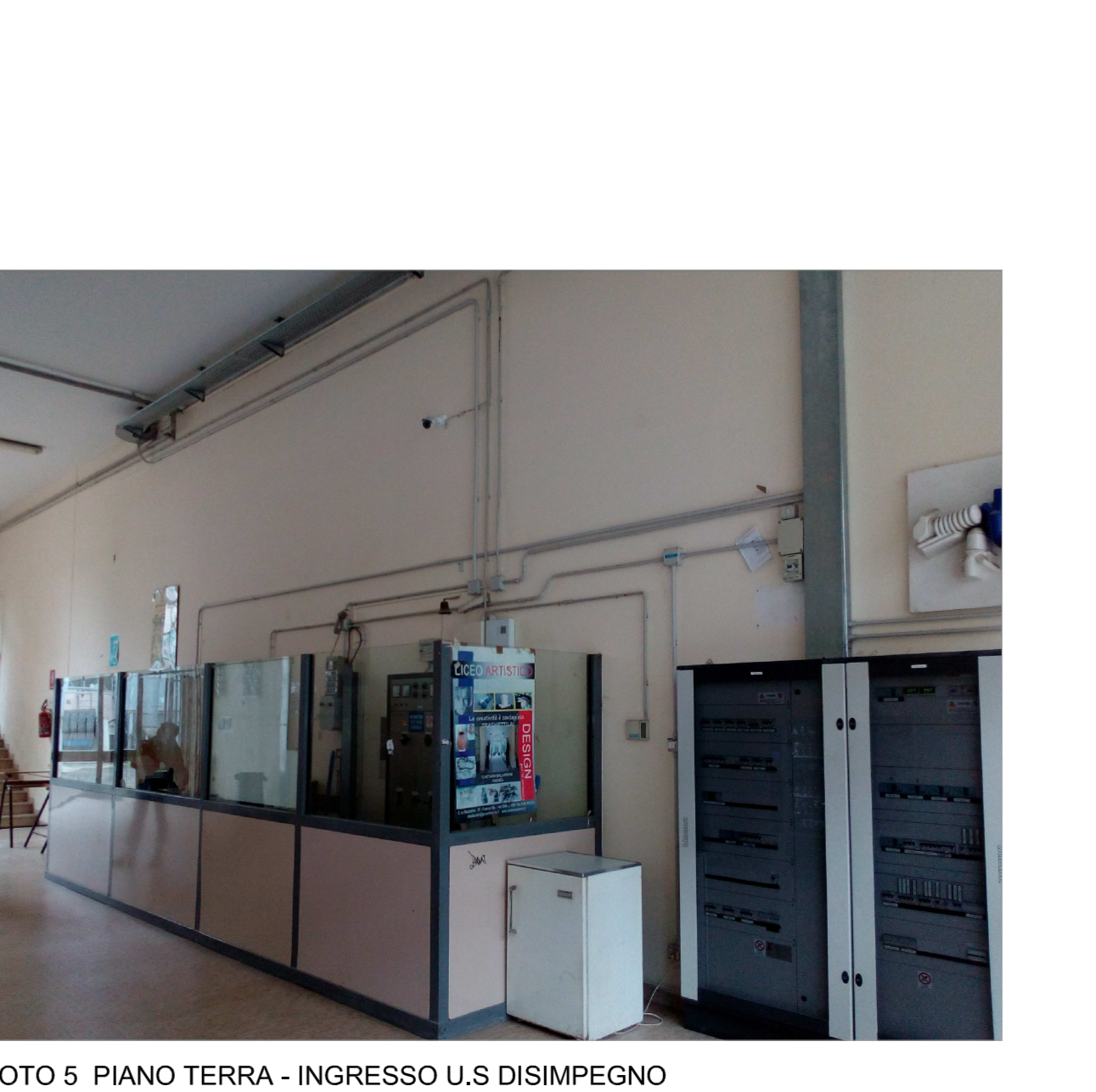
FOTO 5 PIANO TERRA - INGRESSO U.S. DISIMPEGNO
