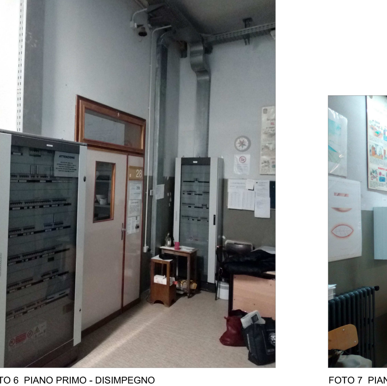
FOTO 6 PIANO PRIMO - DISIMPEGNO
