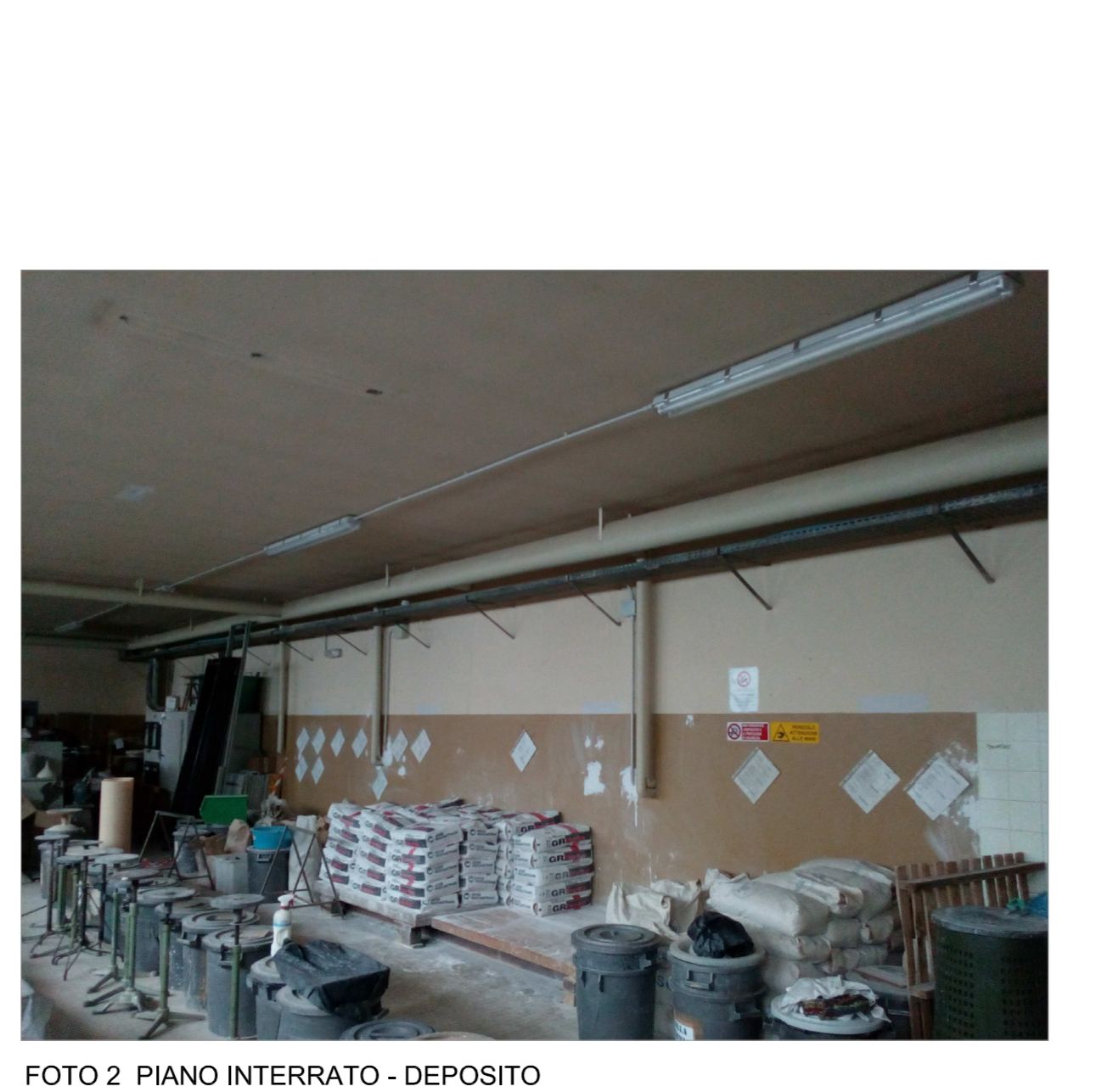
FOTO 2 PIANO INTERRATO - DEPOSITO
