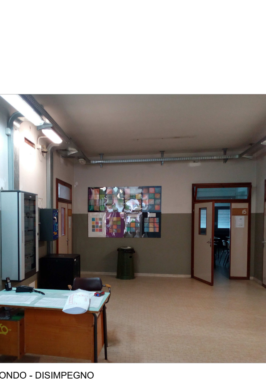
FOTO 7 PIANO SECONDO - DISIMPEGNO
